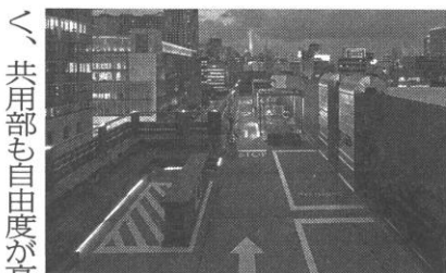
屋上をシェアラウンジに改修(写真: ㈱リソーコ)
